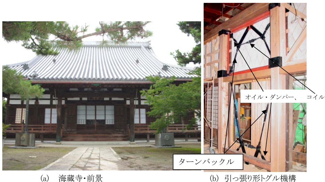
写真-8 海蔵寺の制震改修(2002 年)
