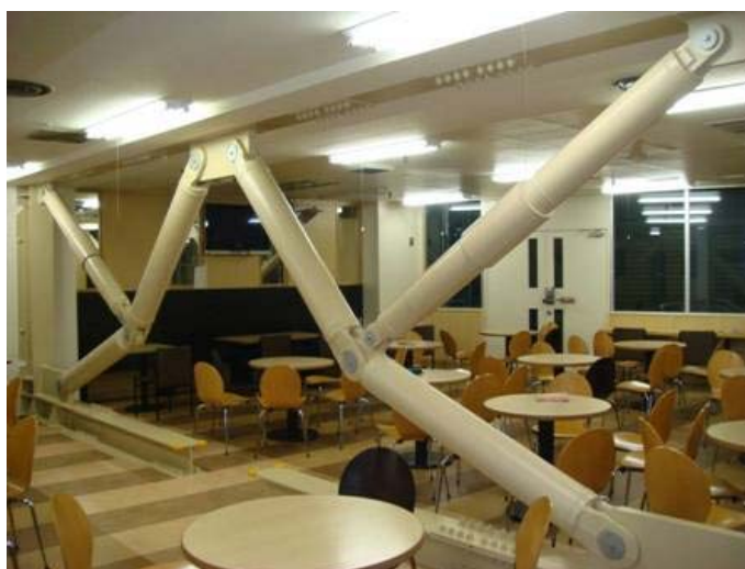
写真-1 トグル機構を利用した制震改修
