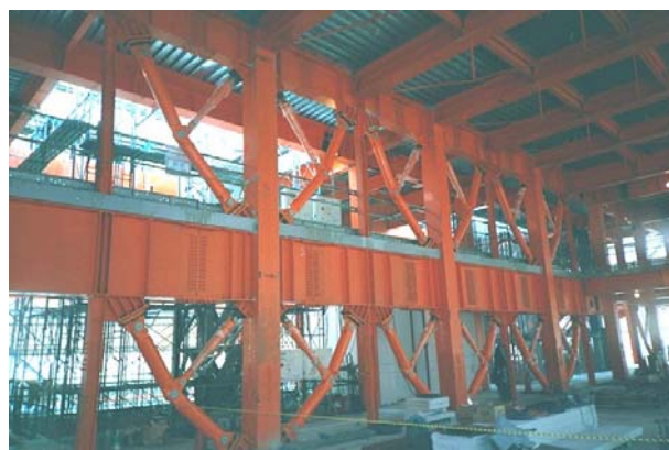
(b)内部のトグル制震装置
